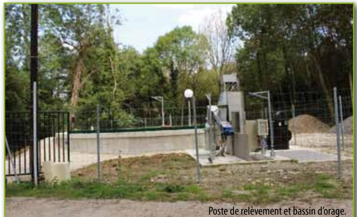
Nous avons construit une station de traitement des eaux usées biologique à boues activées de faible charge, fonctionnant en aération prolongée, c'est-à-dire qu'on laisse la nature faire son œuvre avec des bactéries qui y sont développées pour digérer les pollutions et les transformer en boues.
